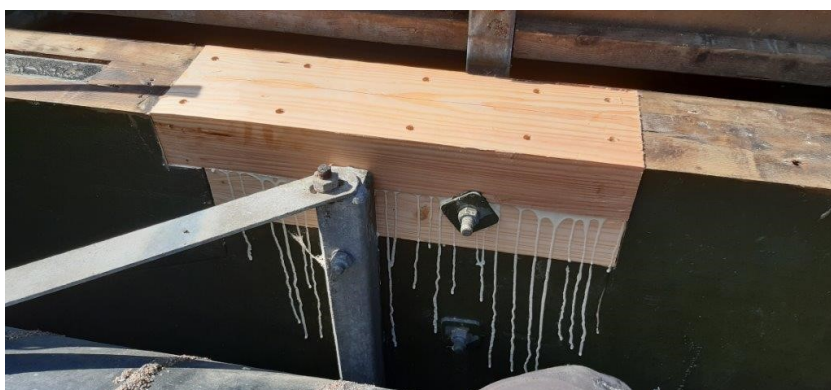
Fig. 2: Træbroer kan gemme på skjulte skader. Broen her, som har vanger i limtræ(fyrretræ), fik nye dækplanker i 2019. I den forbindelse fandt vi et par rådskeer i limtræet, som blev repareret.
